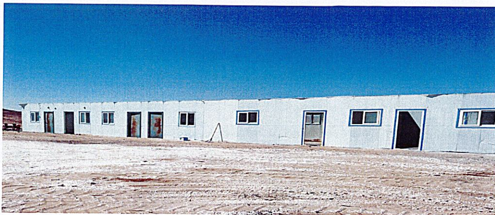
照片1-1 办公生活区板房现状
