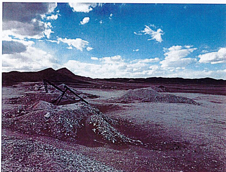
照片1-2 工业广场现状
